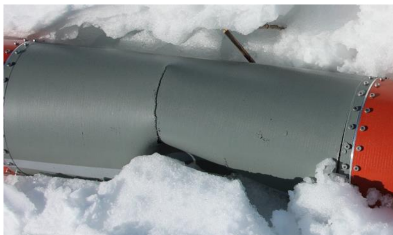
Fig. 3.2.6 破損したタンクチューブ
